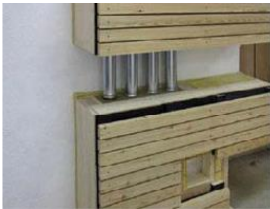
Рис. 2. Реконструкция жилого здания 1952 года постройки, выполненная в 2009 году швейцарской архитектурной фирмой Beat Kaempfen Architects
