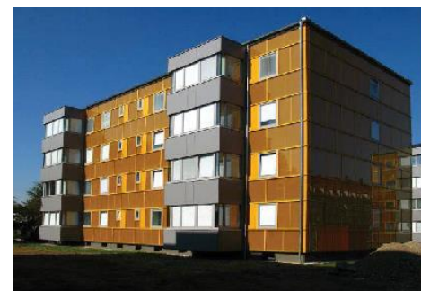
Рис. 5. После реконструкции жилого здания в г. Грац (Австрия) балконы застеклены и расположены в пределах теплового барьера оболочки здания
