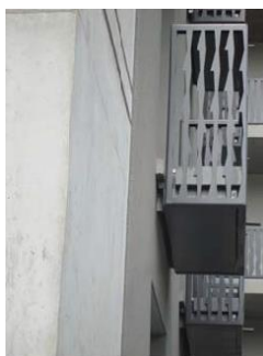
Рис. 3. Присоединение балкона к зданию (Франкфурт-на-Майне, Германия) при помощи металлических кронштейнов.
