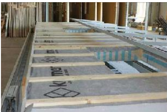
Рис. 1. Изготовление и монтаж крупных панелей фасада реконструируемого здания в г. Грац (Австрия). Фото предоставлены фирмой Gar-solution GmbH, Austria
