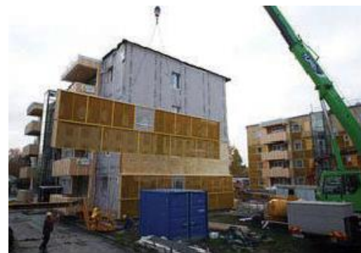
Рис. 3. Элементы фасада со встроенными телескопически соединяемыми воздуховодами. www.empa-ren.ch/A50.htm
